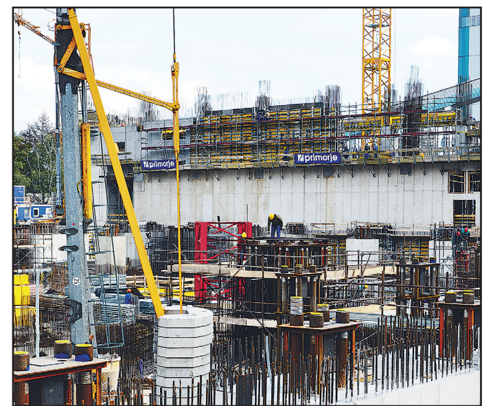
Najbolj intenzivno gradijo ta čas bunkerski del glavnega tehnološkega objekta, trenutno se »pomikajo« od kote 0 do višine 46 metrov.
