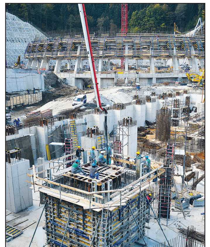
Za hladilni stolp zaključujejo temelje, gradijo pa že prvi obroč.
