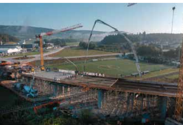
Betoniranje nadvoza Malo Hudo v treh fazah od julija do septembra 2022 (Foto: Nejc Travnik)
