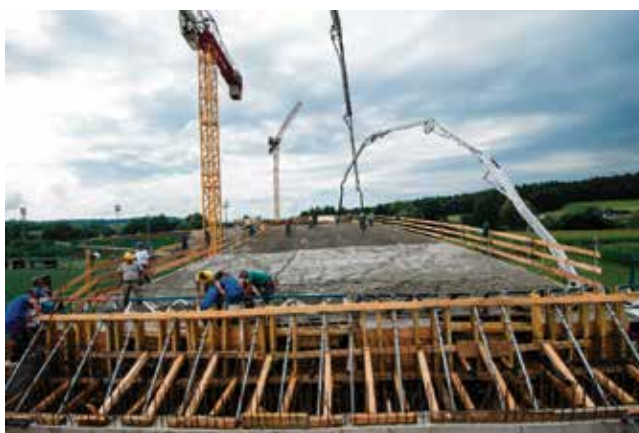
Betoniranje nadvoza Malo Hudo v treh fazah od julija do septembra 2022 (Foto: Nejc Travnik)
