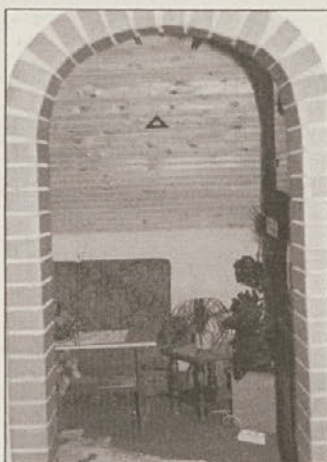
Dnevna soba pred požarom. V požaru je bil uničen lesen strop in sedežna garnitura ter omara. Ostale stvari v sobi so bile močno poškodovane.
