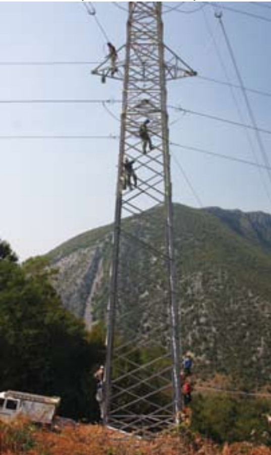
Pleskanje in montažna dela na daljnovidnem stebru.
