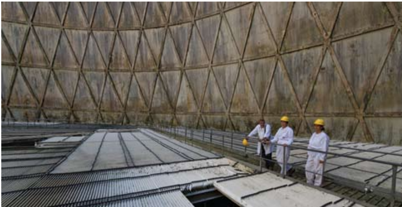
Notranjost hladilnega stolpa B4.
