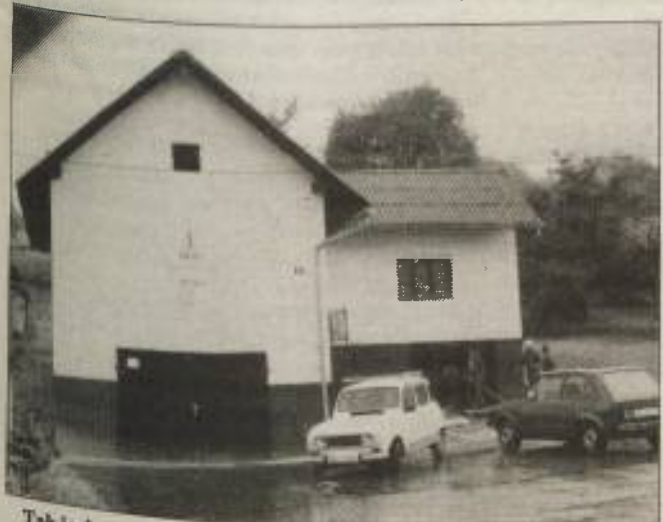
Tak je dom, ki so ga gasilci in drugi občani Krnce gradili več let, te dni pa so v vseh prostorih dali položiti več kot 120 kvadratnih metrov keramičnih ploščic. Vaški funkcionarji pa so pripravljali (in pozneje postavili) koše za košarko.
