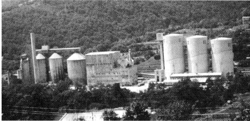
Sl. 5. Končni videz saniranih silosov za beton
