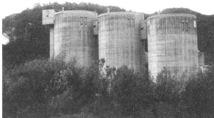
Sl. 1. Silosi za skladiščenje cementa
