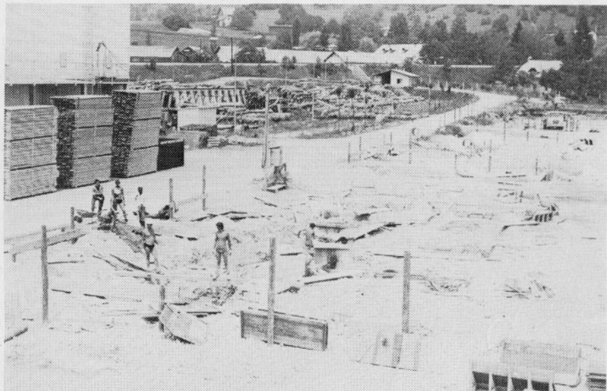
Izkop temeljev proizvodne hale vrat
