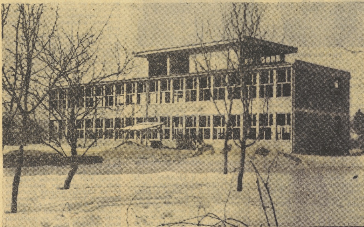
Nova šola v Cerknici, ki jo gradi SGP Gradišče in bo dograjena še letos
