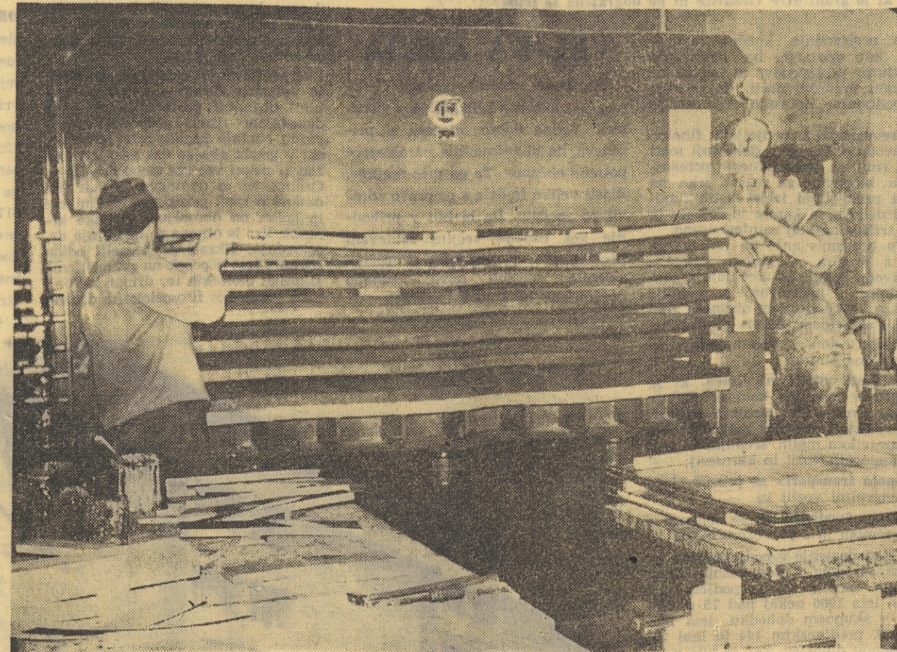
Lesna industrija Gaber v Starem trgu — hidravlična stiskalnica za ploskovno lepljenje
