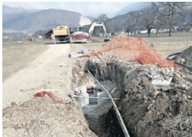
Takole so nov kablovod polagali na Zduši. / FOTO: OBČINA KAMNIK
