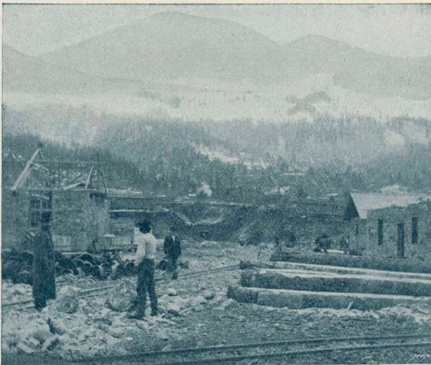
Od bohinjskega predora: Stavbe pred predorom, vrez in vhod v rov, nad njim hišica s strojem za zračenje. V ozadju Črna gora z znamenjem za smer predora.
