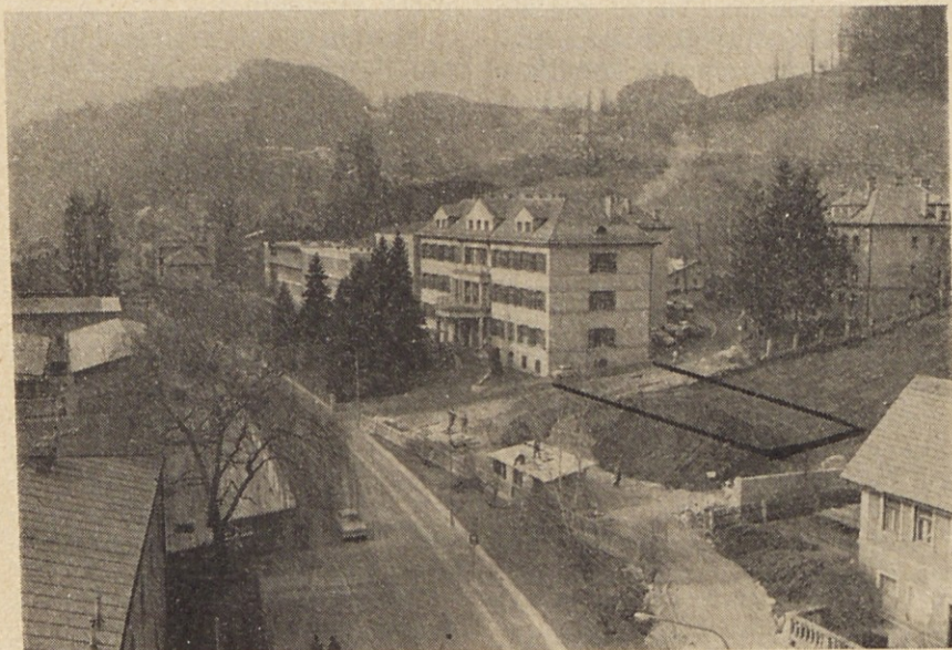
Pričetek gradnje desnega prizidka splošne bolnišnice v Trbovljah, na Volajevem travniku.
