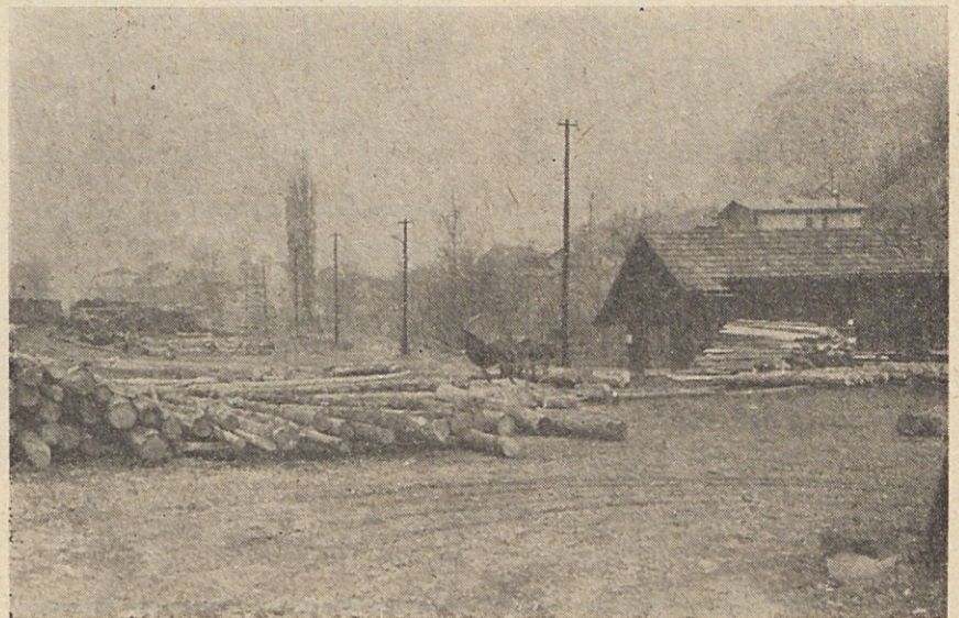
Dosedanje lesno skladišče na rudniku Zagorje, ki bo postopoma ukinjeno v okviru številnih racionalizacij dela. Foto inž. A. Bregant
