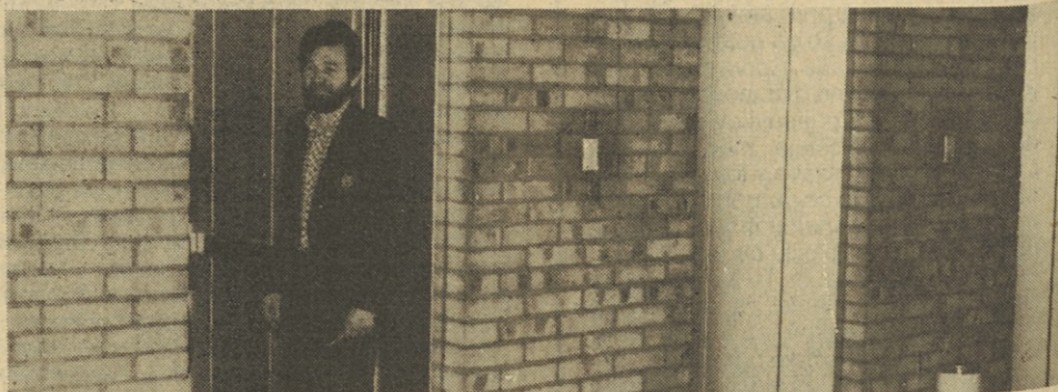
Tehnika švicarskega podjetja Schindler bosta skupaj s tehnikoma Invest servisa čez nekaj dni dokončala prenavo in modernizacijo tovornega dvigala v PPC. Takoj nato pa se bodo skupaj lotili treh osebnih dvigal, najprej skrajno desnega (na sliki). (Foto: Marjan Kralj)
