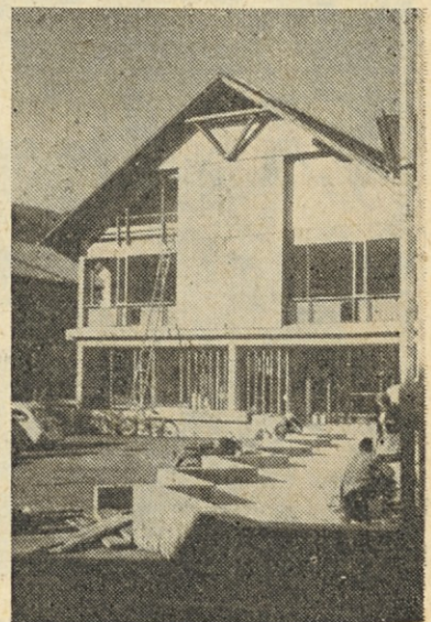
Veledblagovnica Ljubno v gradnji
