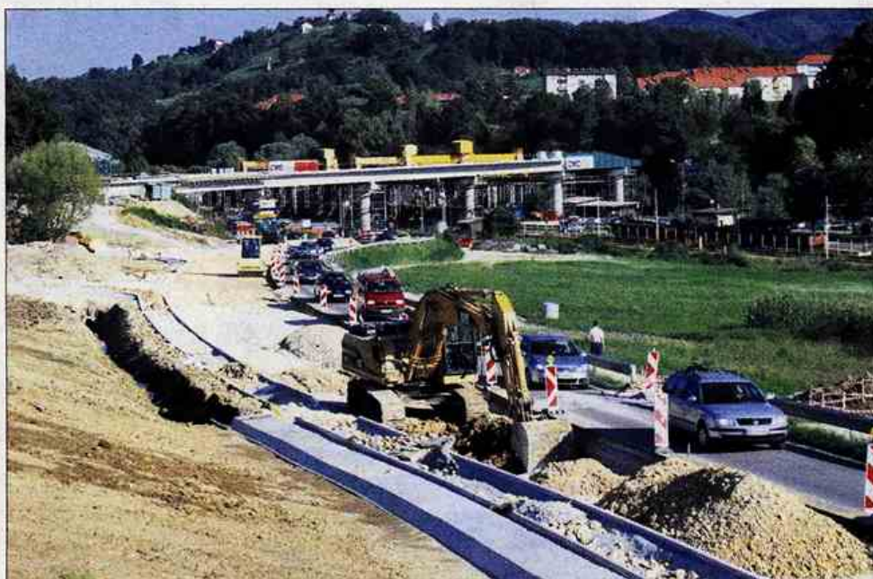
V CMC obljublajo, da bo gradnja nadvoza končana decembra.
