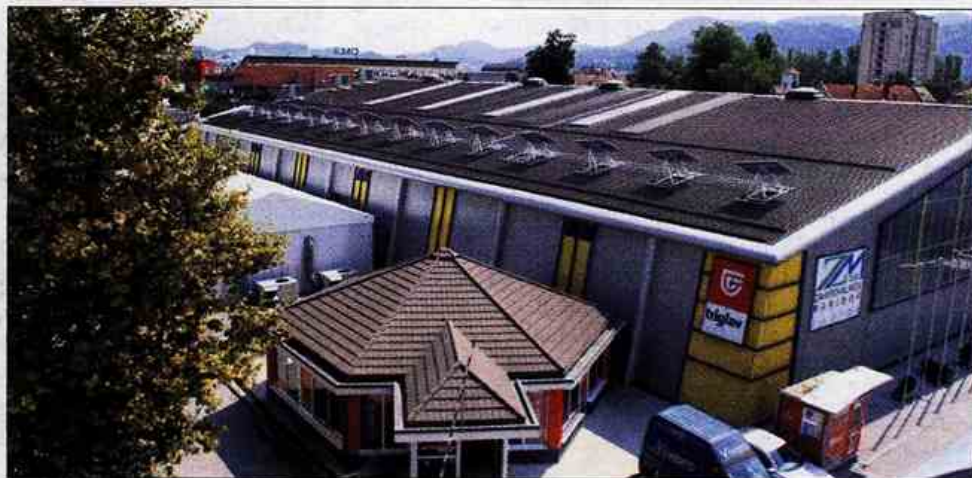
Rdeča nit sejma so alternativne energetske rešitve. Tudi zato bodo na sejmu odprli sončno elektrarno, ki je »zrasla« ne strehi sejemске hale.
