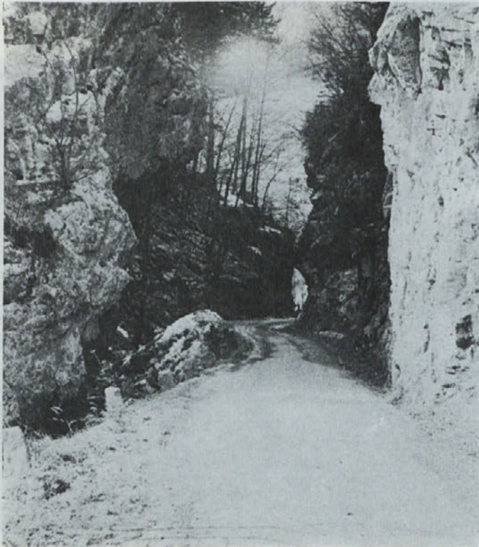
Prevoz v Davčo bo po rekonstrukciji ceste varnejši.
