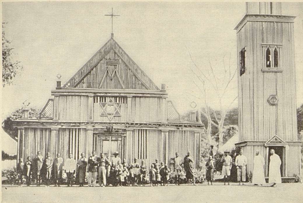
Kirche aus Bambus. — Die Kirche, ganz aus Bambusstäben hergestellt, befindet sich in der katholischen Mission Nyeri in der Kolonie Kenja, Britisch-Ostafrika. Die Consolata-Missionäre von Turin sind dort die Seelsorger.
