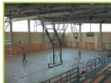
Končana montaža – čiščenje dvorane
