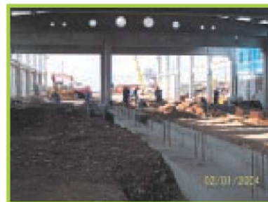
Izdelava temeljev notranjih sten v livnici
