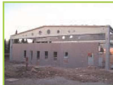
Vzhodna fasada je postavljena
