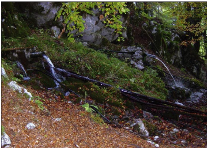
Izvedba zbiralnega bazena (0,5 m 3 ) je v ozadju. Voda mora ves čas teči prek preliva, sicer se črpalka ustavi. Ponovno jo lahko požene le človek.
