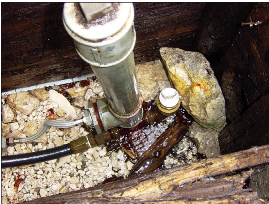
Oven v delovnem okolju in način priključitve dovodne (1") in dvižne (1/2") cevi. Primitivna pritrditev črpalke na podlago še iz časa avtorjevega prvega testiranja naprave je sčasoma postala opravičljiva, ker ne povzroča težav. Zaradi hrupa udarnega ventila črpalko postavimo v zvočno izoliran prostor.
