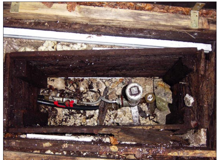
Servisni ventil poenostavi vzdrževanje in zagon črpalke. Omogoča še enostaven izpust vode in dozračenje ovna.
