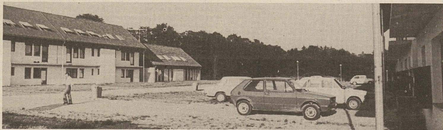
Danes v montažnih vrstnih hišah spodobno stanujejo gradbinci, jutri bodo v njih prebivali delavci ormoške sladkorne tovarne.
