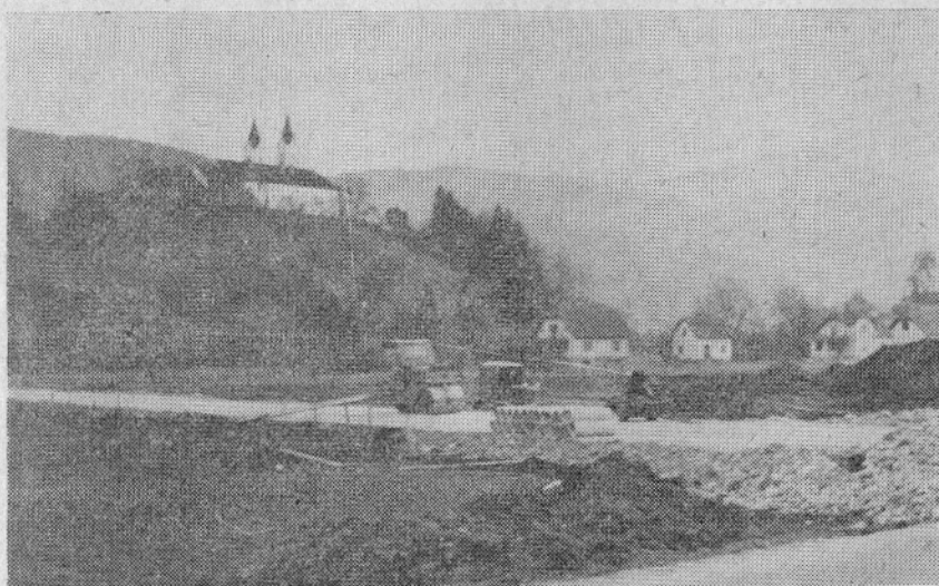
DELA PRI GRADNJI NOVE TOVARNE SO SE ŽE PRIČELA
