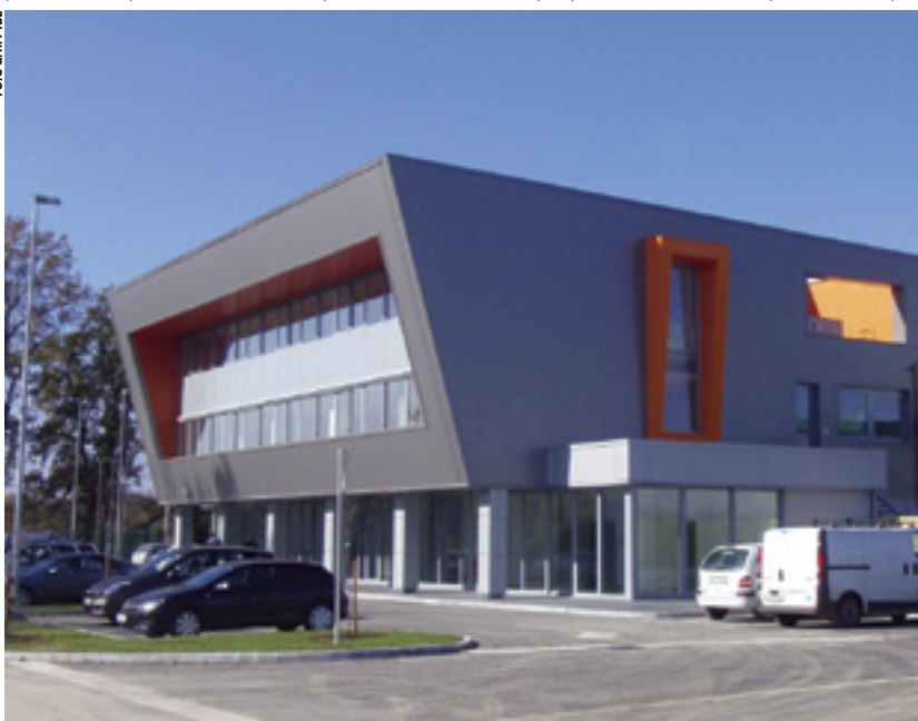
Nov transportno-logistični center družinskega podjetja Habjan transport na Trati pri Škofji Loki.
