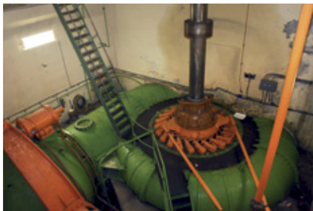
Stanje pred demontažo agregata.
