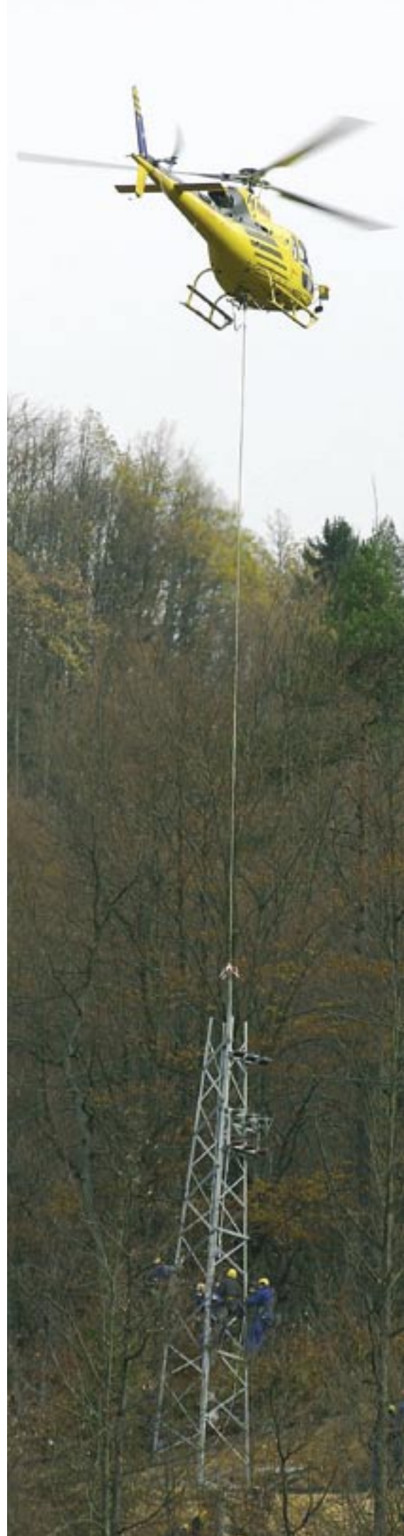
Usklajeno delo helikopterja in monterjev.
