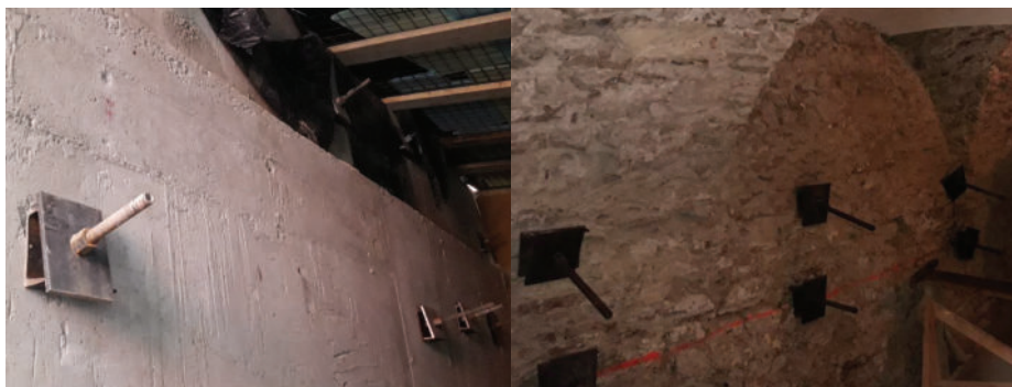
Slika 5 • Armiranobetonski varovalni gredi, izvedeni v dveh nivojih, povezani preko pasivnih sider z obstoječim kletnim zidovjem Stare grofije.
