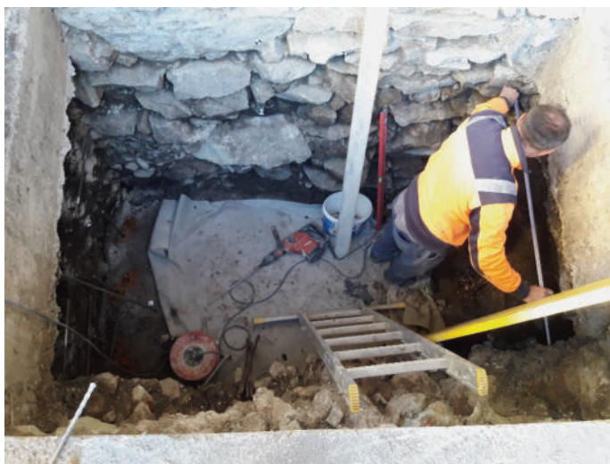
Slika 9 • Območje izkopa globljih vertikalnih kampad podzemnih povezav.
