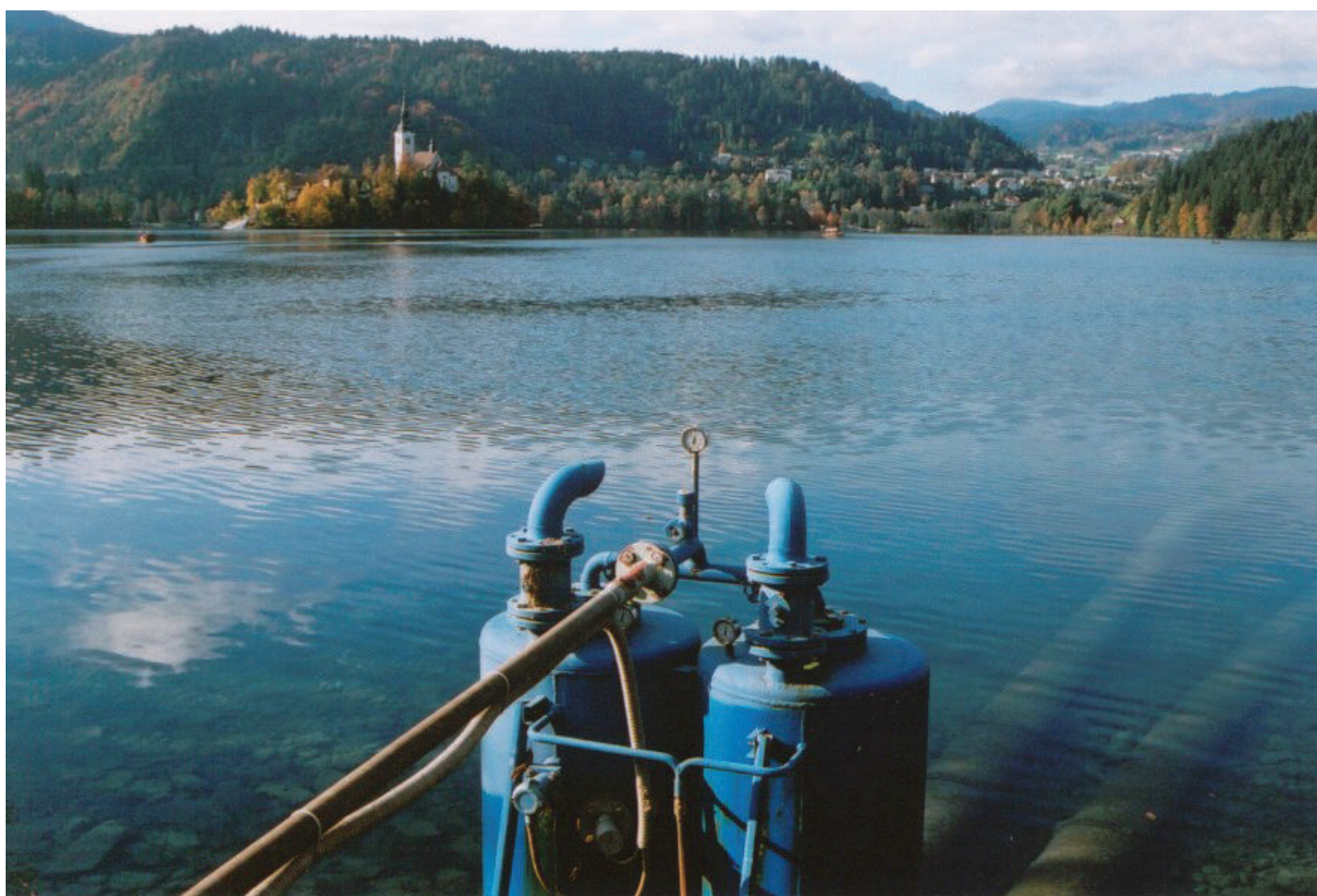
Slika 2 • Natega na Blejskem jezeru. Dva cevovoda (kraka natege) vlečeta anoksično vodo iz hipolimnija ven iz jezera, medtem ko sveža voda iz Radovne priteka v jezero.
