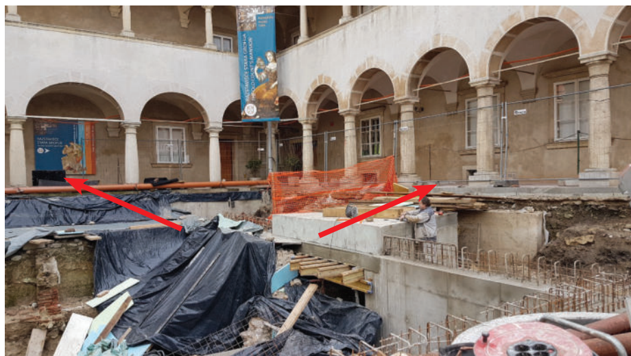
Slika 2 • Pogled na zahodni in severni arkadni hodnik zgradbe Stara grofija, gradbišče objekta za zaščito arheoloških ostalin, ter z rdečima puščicama nakazani smeri vzhodne in južne podzemne povezave.
