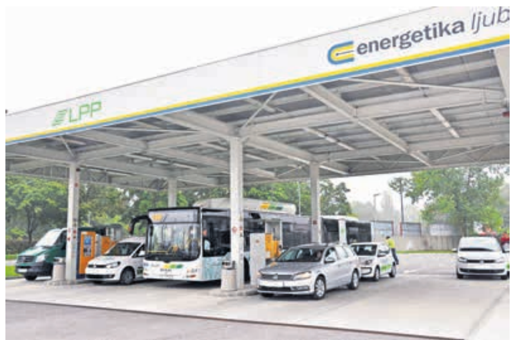
Zemeljski plin se v stisnjeni obliki uporablja tudi kot pogonsko gorivo (CNG). V Ljubljani sta trenutno aktivni dve polnilnici, v Šiški in na Dolgem mostu, do konca leta bo postavljena še ob Letališki cesti in prihodnje leto na parkirišču P+R v Stanežičah.
