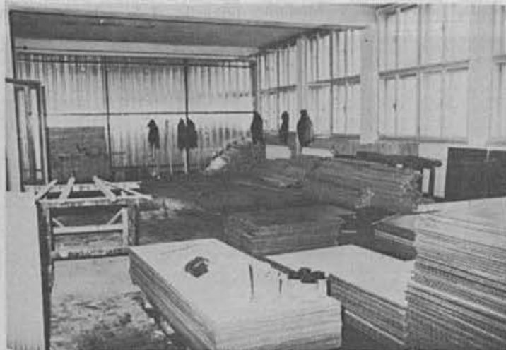
V III. nadstropju stare stavbe delavci Mizarskega podjetja v so-delovanju z našimi adaptirajo
