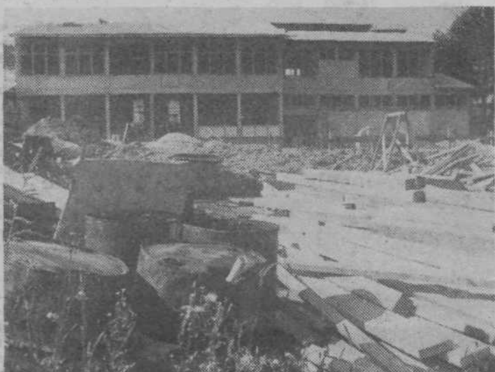
OSNOVNA ŠOLA IN VVZ V DOLSKEM — Je to gradbišče ali odlagališče odpadnega materiala, se najbrž sprašujejo marsikateri domačini ali drugi mimoidoči, ko si ogleduje poslopje in njegovo okolico. Na gradbišču je moč najti vse. Popolnoma nov gradbeni material je pomešan z nerabnim. Tu so deske, pa prazni sodi, robniki, kocke za tlakovanje, kupi odpadnega ometa in še drugo. Pogled na to res nikomur ne more zbuditi zaupanje v graditelja
