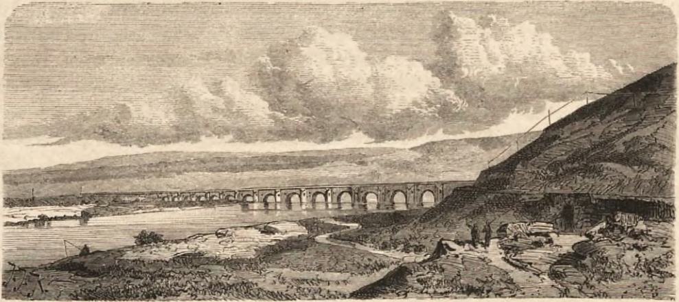
Jantrabrücke bei Bela.
