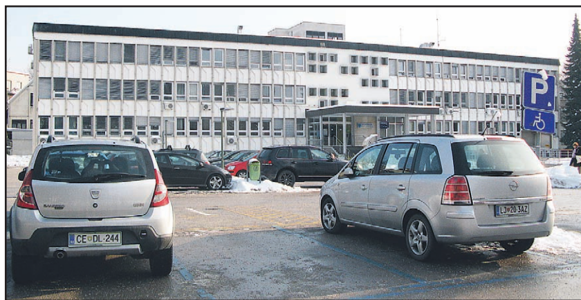
Na parkirišču pred velenjskim zdravstvenim domom bo v okviru prenove promenade »zrasla« nova enonadstropna garažna hiša, kar bo število parkirišč tam podvojilo.
