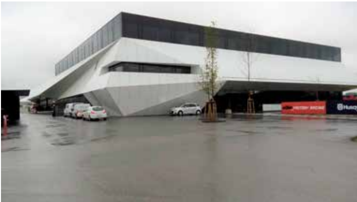
KTM veliko daje na zunanjo podobo. To je razvidno tudi iz sodobne arhitekture zgradbe, ki navzven sploh ne izdaja, da gre za proizvodni obrat, v katerem nastajajo pogonski agregati.
