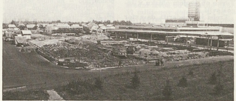
Gradnja mehanične delavnice poteka pospešeno. Delavci si prizadevajo, da bi bil objekt do zime pod streho.
