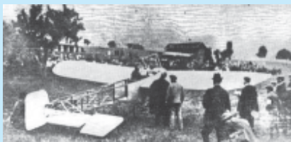
□ Slika 3. Letalo Blériot XI. Nizkokrilnik s paličastim trupom, podvozjem in že kar modernimi krmili. Trivaljni motor je zmogel vsega 19 kW.
