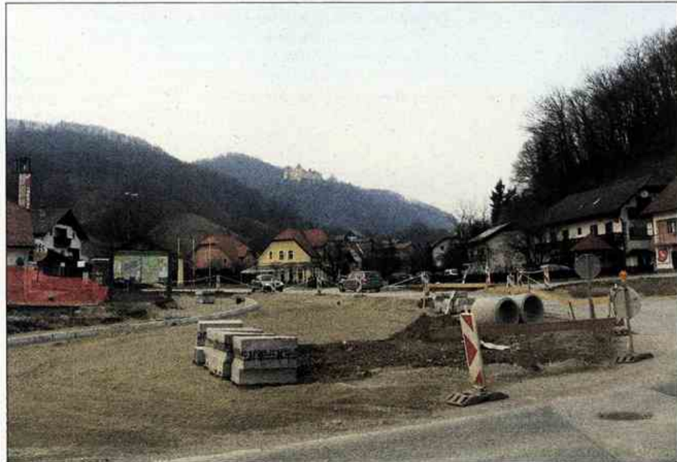
V turističnem trgu Podčetrtek potekajo obširna gradbena dela, med katerimi bodo poskrbeli na vstopu v naselje za novo prometno ureditev. Prometno zagato proti Olimju bodo rešili z dodatnim krožiščem.
