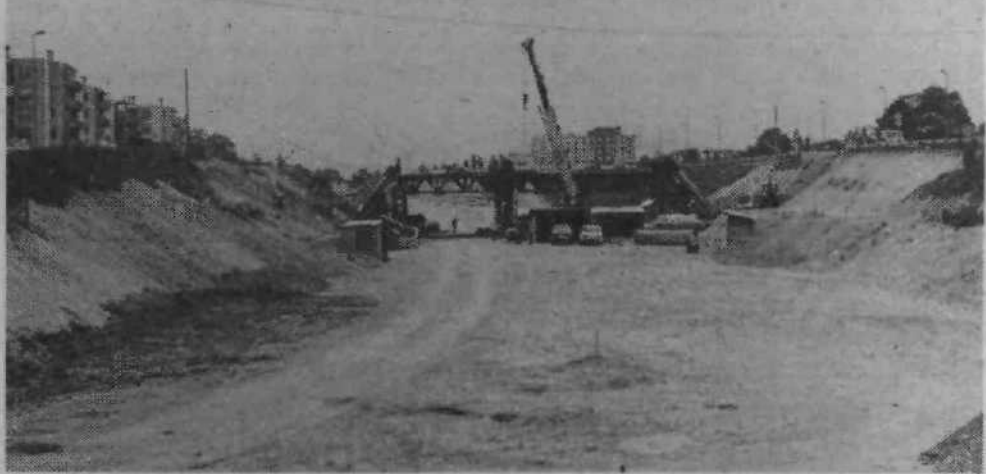
V gradnji pa je tudi nadvoz nad severno obvoznico v podaljšku Hošimihove ceste, ki bo dolg 55 metrov, širok 16 metrov in bo imel na obeh straneh pločnik. Predvidevajo, da bo dograjen do konca oktobra.
