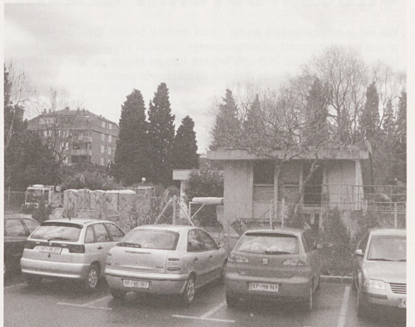
Staro črpališče odpadnih voda. Tudi tu bo veliko gradbišče, saj bodo zgradili novo črpališče in zadrževalni bazen.
