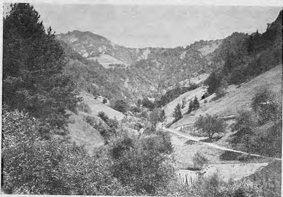
Mačkov potok — sedaj. Po ureditvi struge in vezanju pobočij so se erozijske poškodbe popolnoma zarasle, hudournik pa umiril. (Primerjaj zgornjo sliko!) (Foto F. Rainer, 1955)
