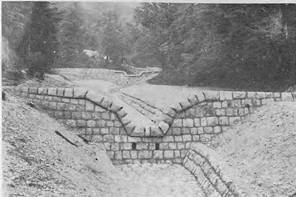
Matušev jarek v Ukancu ob Bohinjskem jezeru. Hudournik je urejen in tujskoprometna važna cesta ob jezeru ni več ogrožena; odstranjena je nevarnost pred zasipavanjem zemljišč in jezera. (Foto: F. Rainer, 1954)
