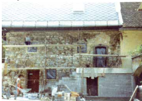
Prenavljanje Kranjčeve hiše (foto last: M. Kranjc)
