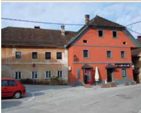
Pročelje Briceljeve hiše (foto: Franci Dovč).
