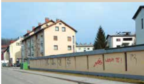
Stanovanjski bloki na Voljčevi cesti 4 (foto: F. Dovč).
