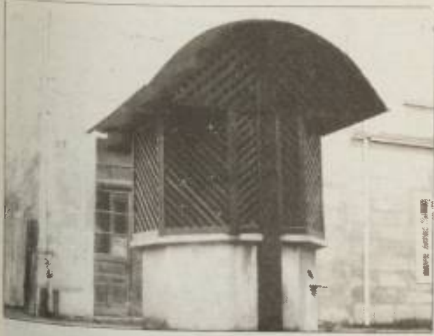
LENDAVA, vodnjak pred hišo Kranjčeva ulica 13 Pred hišo v Kranjčevi ulici št. 13 stoji vodnjak z betonsko bazo in leseno nadgradnjo. Vodnjak je zgolj ambientalnega pomena.
