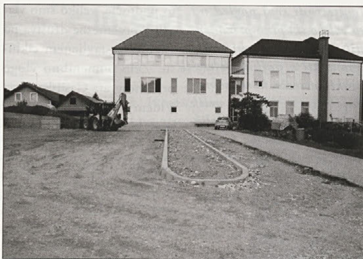
Zdaj je na vrsti tudi ureditev parkirišč za zaposlene v OŠ Leskovec in tamkajšnjem vrtcu.
