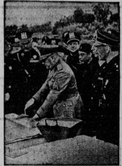
Mussolini polaga temeljni kamen za novo rimsko cesto »Via Imperiale«.
