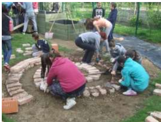
SLIKA 2: Gradnja spiralne grede.
