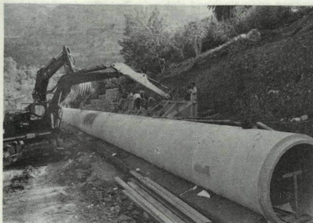
Slika 1: Polaganje cevi premera 1600 mm v »boljših« pogojih
