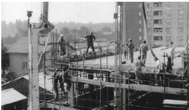
Gradbena dela na prizidku za predmetno stopnjo, 1980
