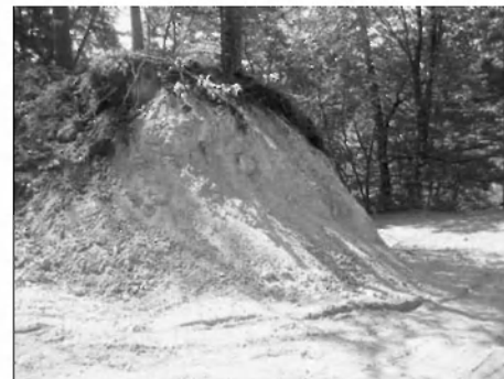
Gradbena dela na lokalni cesti Turjak–Podturjak
