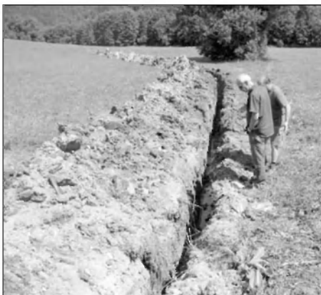
Gradbena dela za vodovod od Roba proti Podhojnemu hribu
