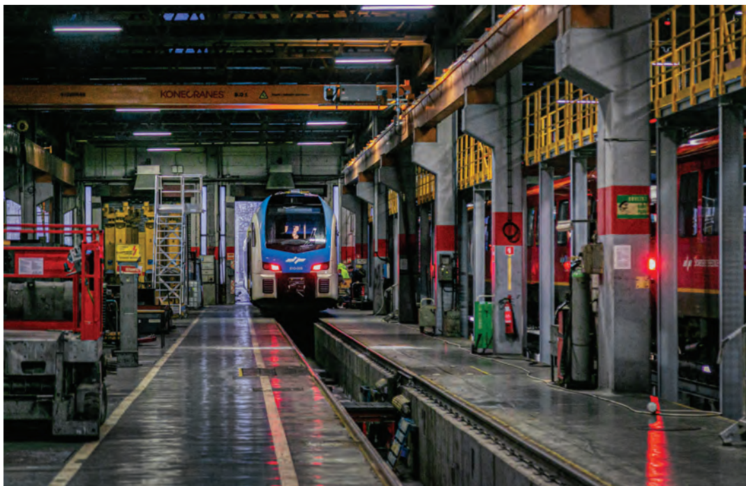
Delavnica vzdrževalnega centra SŽ-VIT v Ljubljani je posodobljena in ustrezno opremljena za vzdrževanje vseh vrst železniških vozil, ki vozijo pri nas.
