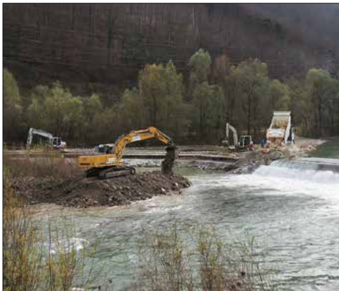
Na Delejevem jezua v mozirski občini izvajajo podbetoniranje, zamenjavo lesenega nadkritja na obstoječih stopnjah in »ribjo stezo« za prehod vodnih organizmov. (Foto: Igor Solar)
