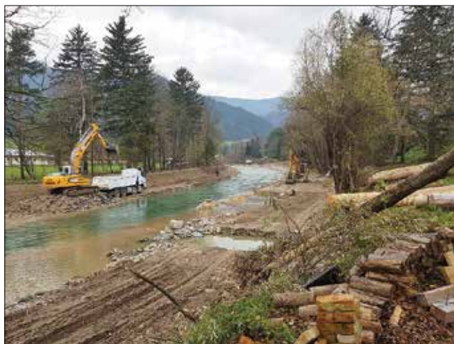
Obsežna sanacijska dela na Savinji v Vrbju v občini Ljubno (fotodokumentacija Občine Ljubno)
