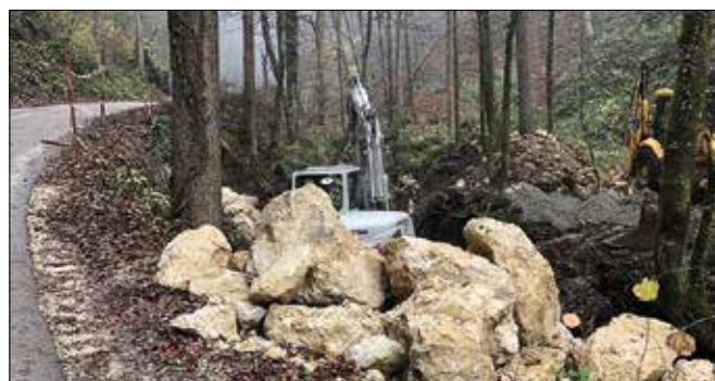
Sanacijska dela na brežini Gračance (fotodokumentacija Občine Ljubno)
