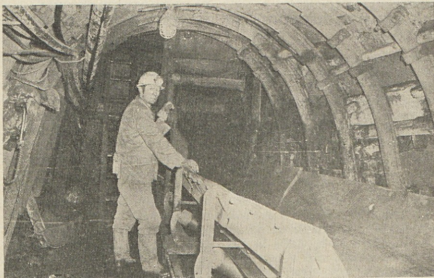
Izsipavanje nakopanega premoga iz zavojnih drč na gumijasti trak na koti 150 v južnem krilu Javor sloja v jami Ojstro. foto A. Bregant
