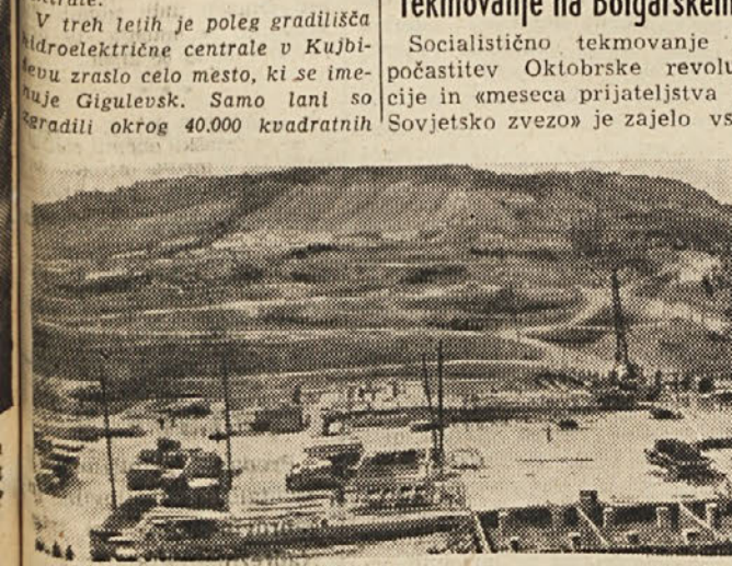
Delni pogled na velikansko gradilišče v Kujbiševu
