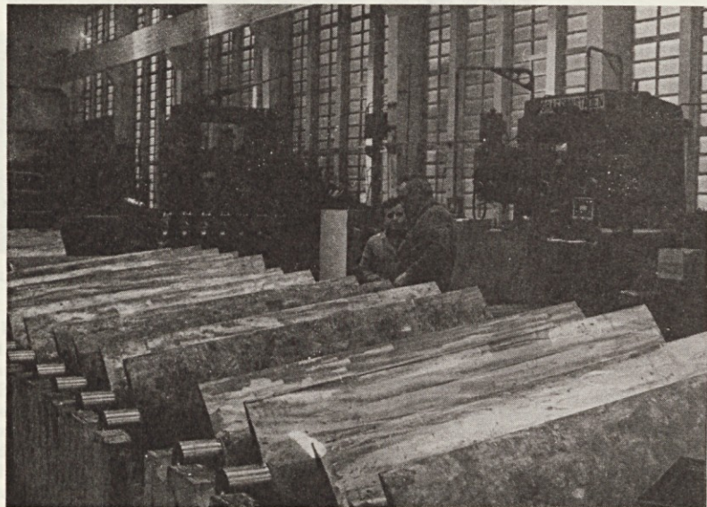
Vodilne lopate za HE Dubrava. Zadnji pregledi po mehanski obdelavi in vgraditvi v vodilnik turbine
