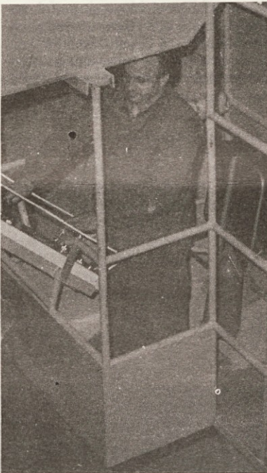
Jaka Bradeško na svojem delovnem mestu pod stropom elektrarne
