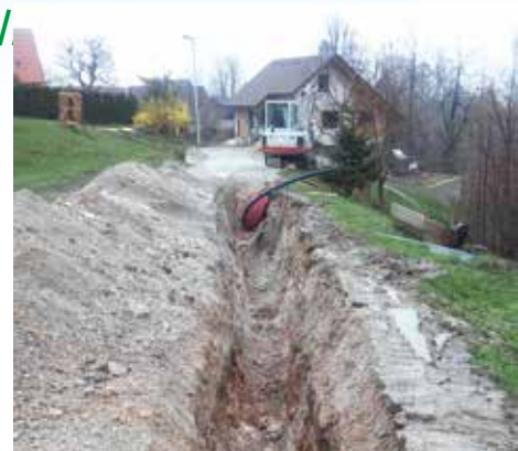
Obnova dela vodovoda v Zapotoku
