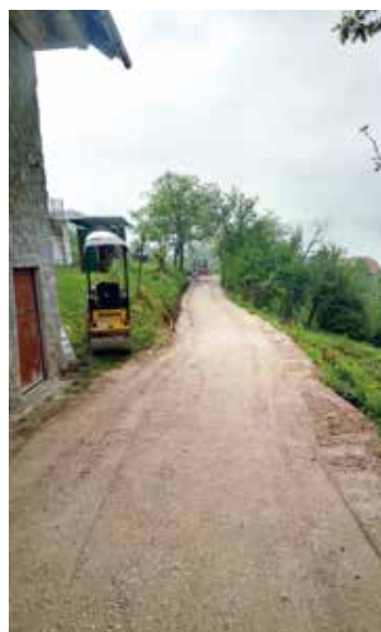
Rekonstrukcija ceste na Sarkem v sklopu projekta Ureditve lokalnih cest v Občini Ig 2017 in 2018.
