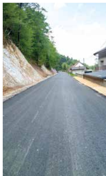
Na regionalni cesti Podkraj-Podpeč se izvaja rekonstrukcija dotrajane ceste. Dela izvaja podjetje Trgograd d.o.o.
