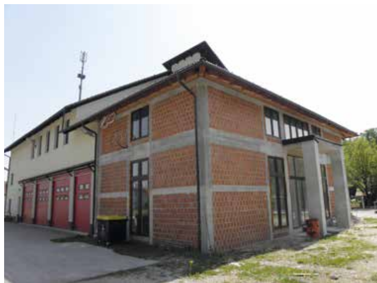
Gradnja prizidka – dvorane napreduje.
