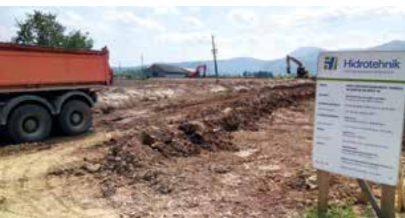
Gradnja protipoplavnega nasipa
