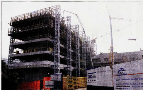
Prva stavba v Tehnopolisu bo imela 5.000 kvadratnih metrov bruto površine, vseljava pa naj bi bila že oktobra.
